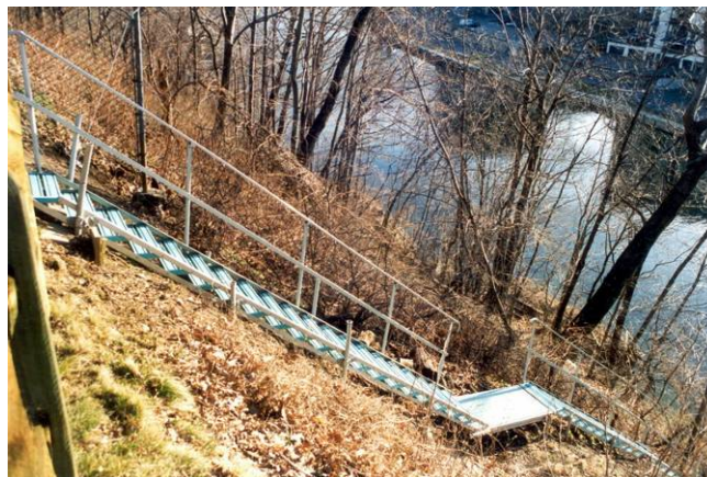
Przykłady aluminiowych schodów spoczywających bezpośrednio na zboczu ziemnym
