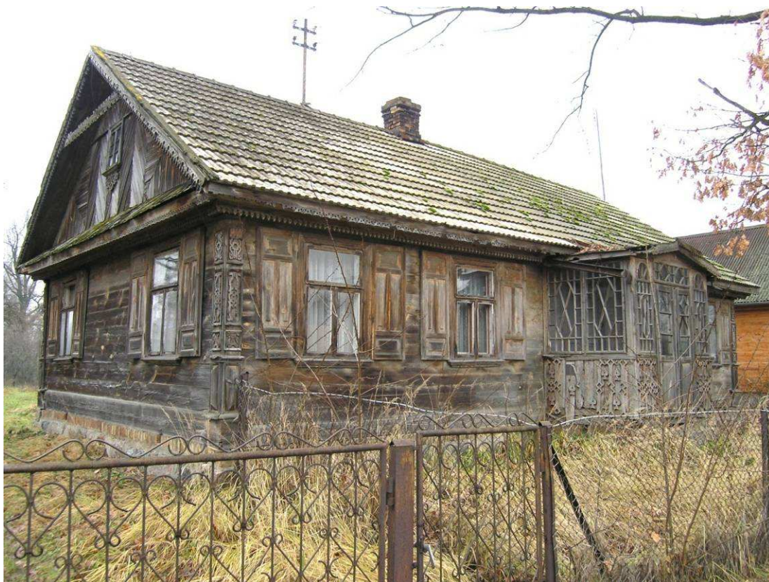
Il. nr 7. Budynek mieszkalny nr 24.
