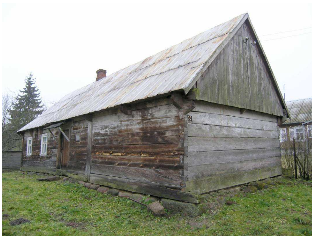
Il. nr 5. Budynek mieszkalny nr 35.
