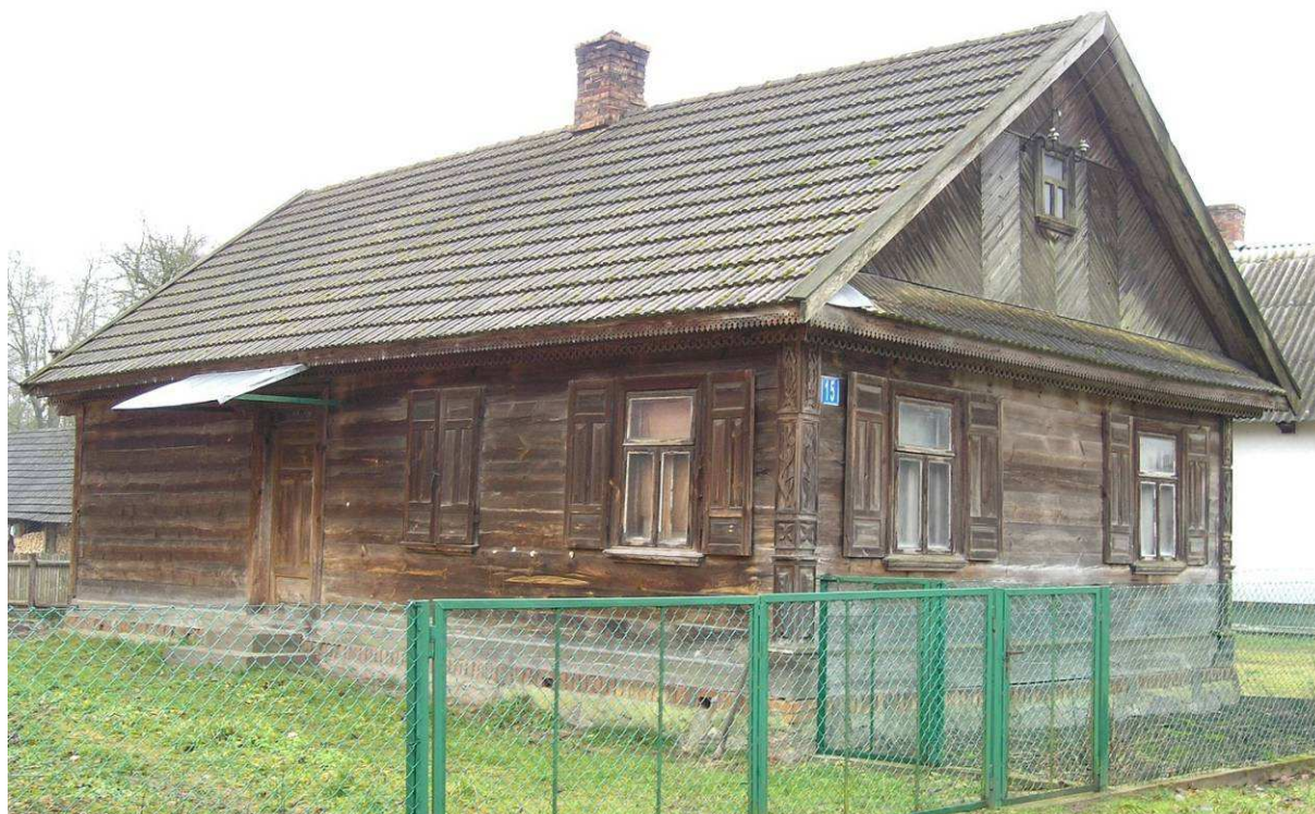
Il. nr 8. Budynek mieszkalny nr 15
