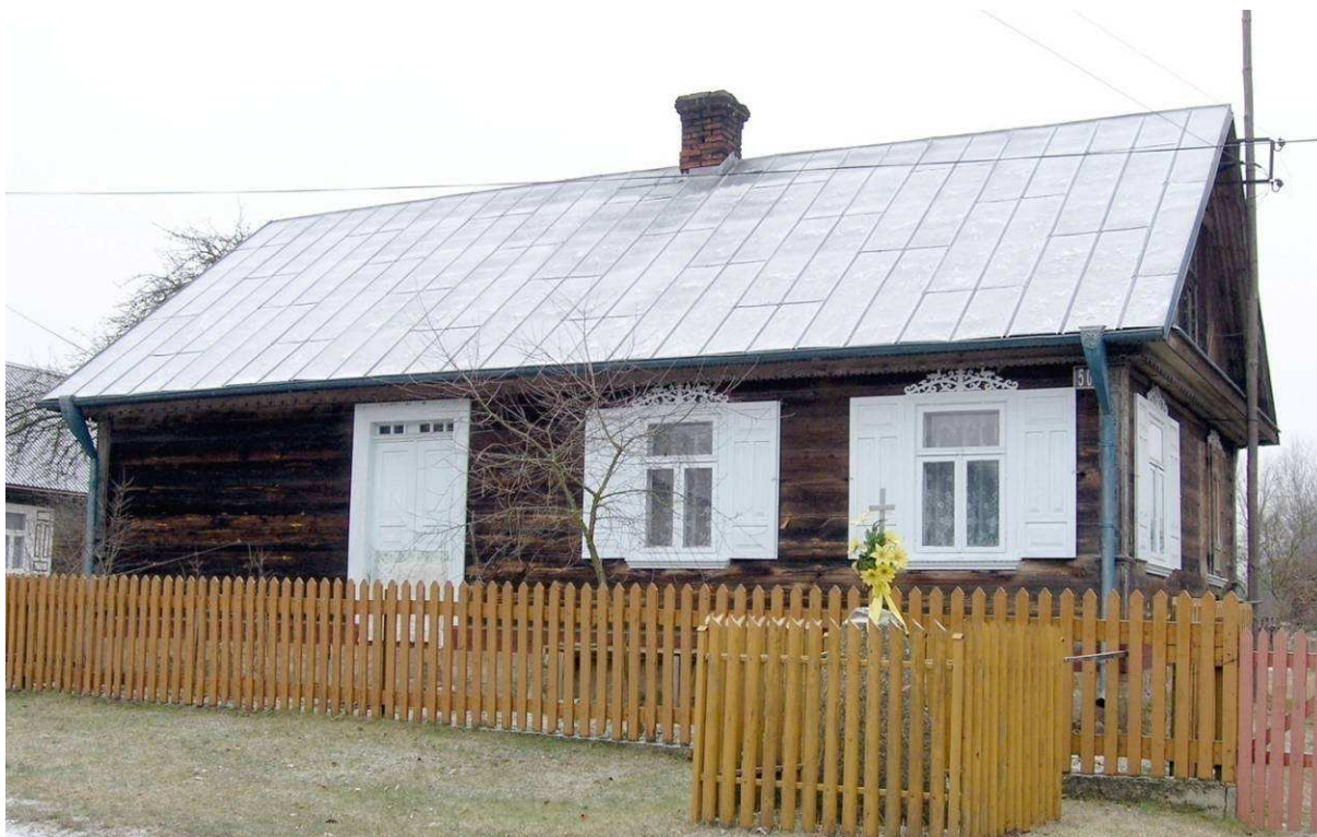
Il. nr 9. Budynek mieszkalny nr 50.
