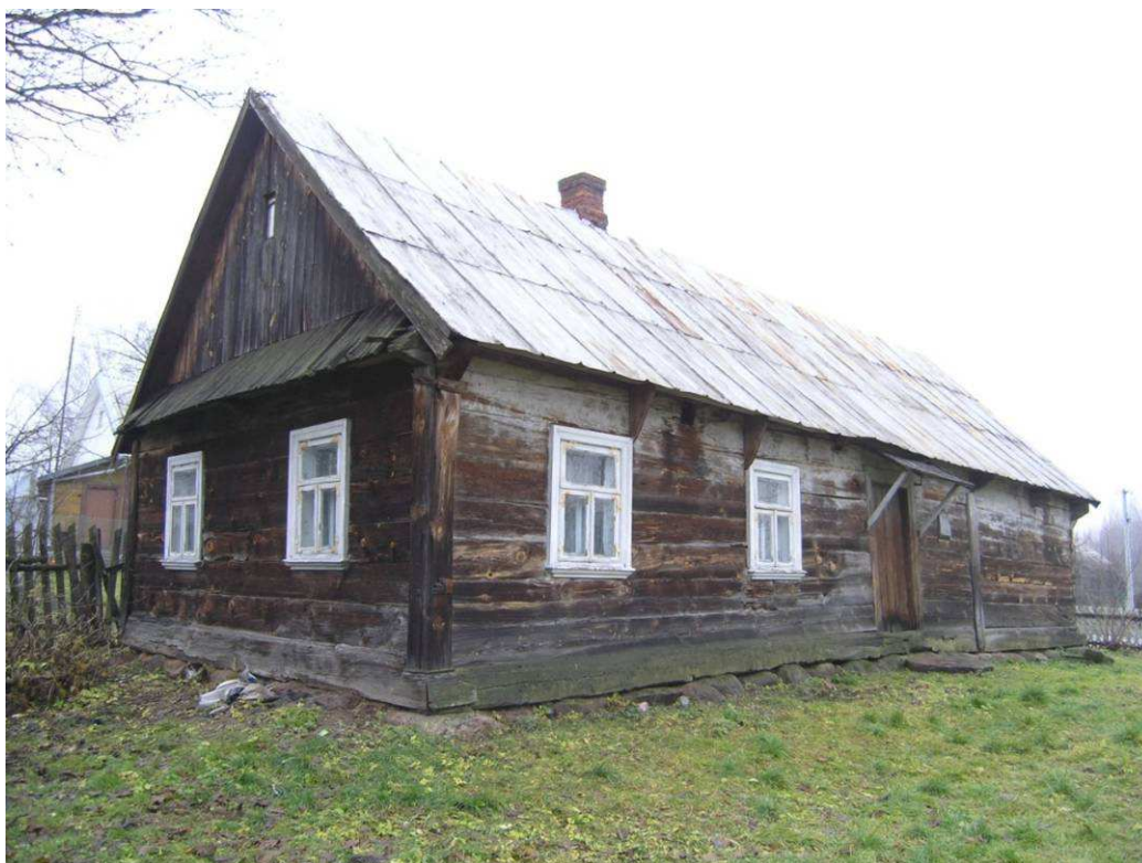
Il. nr 4. Budynek mieszkalny nr 35.
